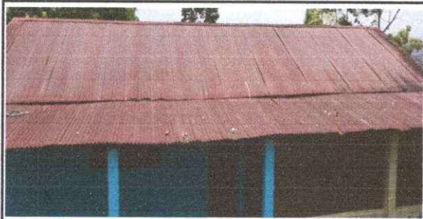
Foto 3: Sustitución de lámina, por lámina troquelada aluzink calibre 26 original. Molulo 2
