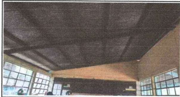
Foto 2: Mantenimiento de estructura de soporte Modulo 1
