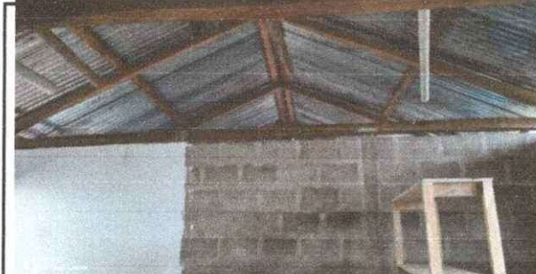
Foto 4: Sustitución de estructura de sopoete de madera, por metal.
