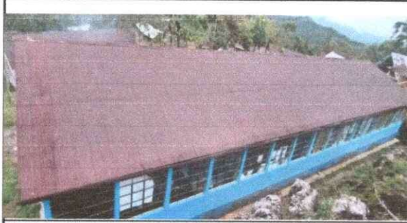
Foto1: Sustitución de lámina, por lámina troquelada aluzink calibre 26 original. Molulo 1
